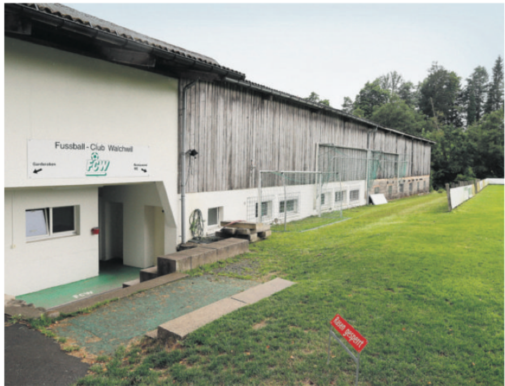
Kann endlich abgebrochen werden: Der alte Schuppen des Fussballclubs Walchwil auf dem Lienisberg hat ausgedient.
