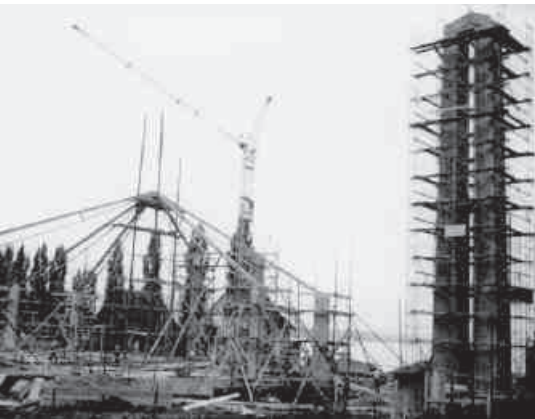
Kirchenbau 1956 im Gerüst
