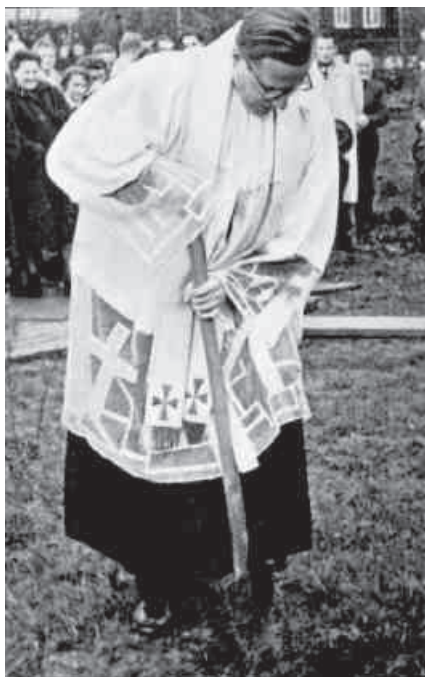
Erster Spatenstich am 11.12.1954
